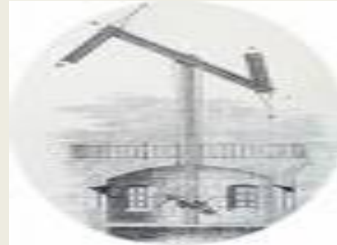
Telégrafo óptico de Chappe
